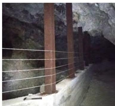
**Fig. 7** - Ringhiera di protezione in cls e cavi, "butte" in ferro a sostegno della volta.
