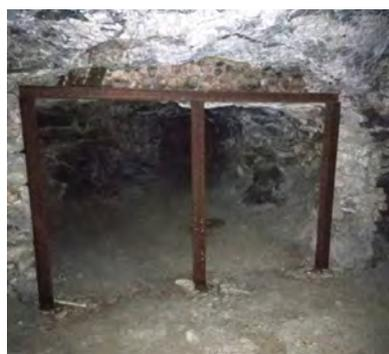
**Fig. 6** - Centine in ferro con montante centrale, rete e bulloni "in corona".
