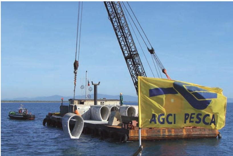
Fig. 2 - Messa in opera delle barriere di ripopolamento.
